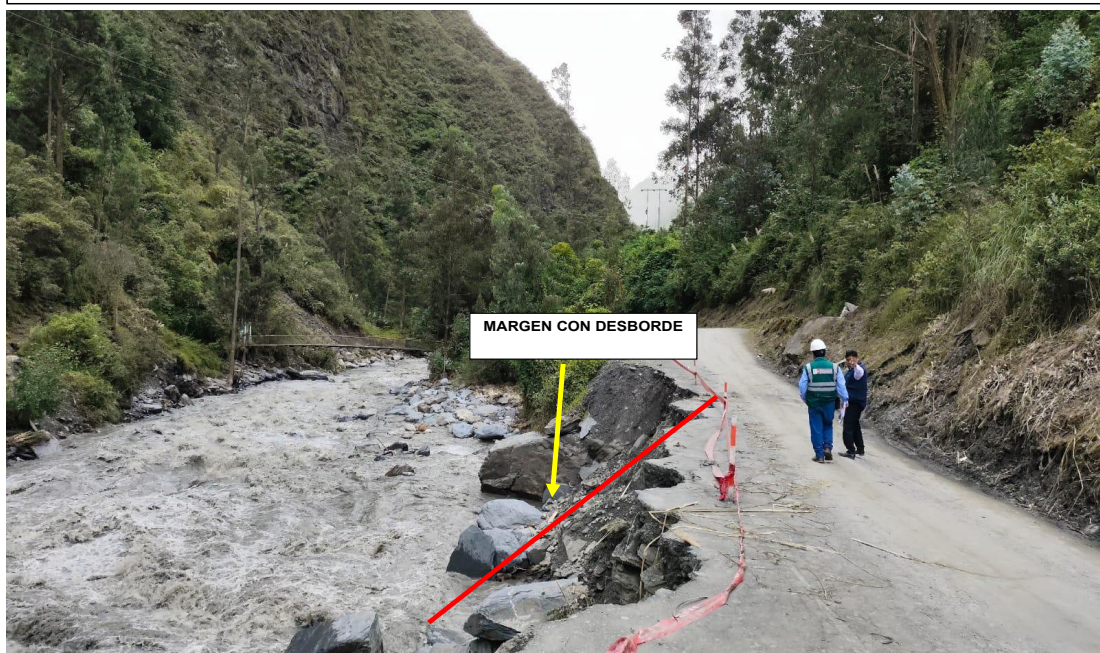
FIGURA N° 02: SOCAVAMIENTO DE CARRETERA QUE VA AL DISTRITO DE ALTO INAMBARÍ Y DISTRITO DE YANAHUAYA.
