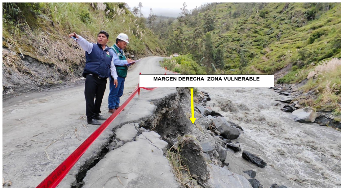
FIGURA N° 01: SOCAVAMIENTO DE CARRETERA QUE VA AL DISTRITO DE ALTO INAMBARÍ Y DISTRITO DE YANAHUAYA.
